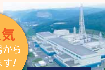
柏崎刈羽原子力発電所
